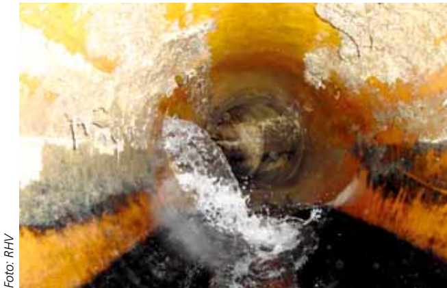
Undichter Kanal
