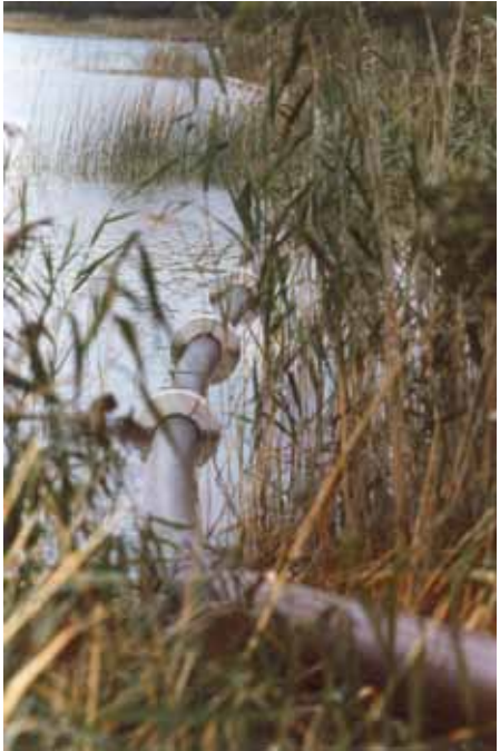
Abb. 6: Seeleitung im Grabensee vor der Absenkung
